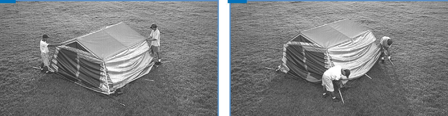
折り曲げておいた脚フレームのジョイントを片側から順につなぎテントを建ち上げます。その後、脚フレームが幕体の縫い目と合うように脚フレームの位置を調整してください。
