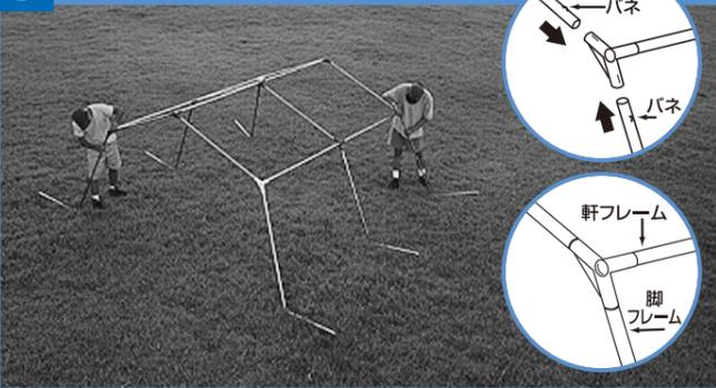
まず、屋根部から組み立てます。軒A、棟、軒Bをそれぞれ合掌でつなぎます。合掌に付いているパネはジョイントの穴にしっかりと差し込んでください。次に脚を片側から順にジョイントに差し込みます。この時、幕体をかぶせやすいように脚は写真のように折り曲げたままにしておいてください。また、脚上部に付いているパネをジョイントの穴にしっかりと差し込んでください。
