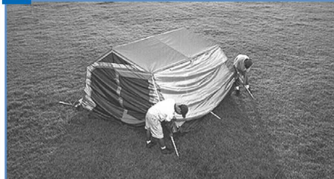
折り曲げておいた脚フレームのジョイントを片側から順につなぎテントを建ち上げます。その後、脚フレームが幕体の縫い目と合うように脚フレームの位置を調整してください。
