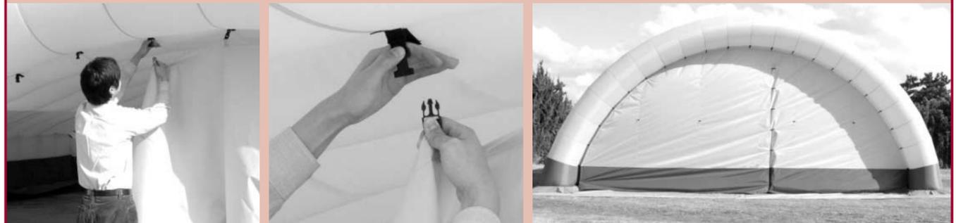
**b 前・後面幕を取り付ける場合** 送風を開始して約15分位経過すると各チューブにエアが行き渡り、前・後面の頂上部が地面から浮き上がります。その時に前面幕2枚、後面幕2枚の上端に付いているバックル(♂)を前・後面チューブの内側にあるバックル(♀)と接続します。
