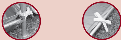
四隅を縛りテープで支柱、中支柱に固定します。 縛りテープを裾パイプに固定します。
