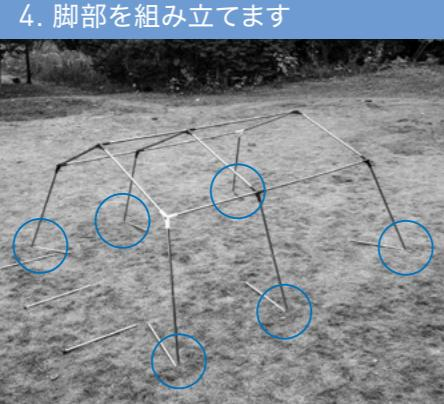
次に、脚を片側から順にジョイントにしっかりと差し込みます。この時、幕体をかぶせやすいように脚の一番下の一節を折り曲げたままにします(○)。
